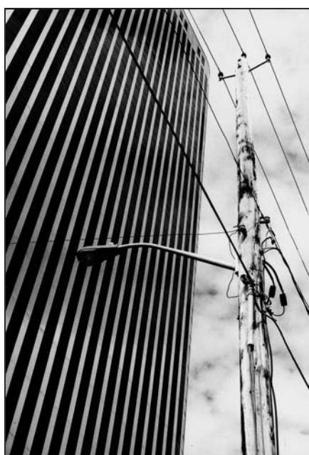
dřevěné stožáry VN a NN vedení jsou pro Kanadu typické a nalezneme je i v centru hlavního města Ottawy
