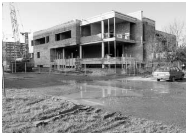
stavba nové budovy
