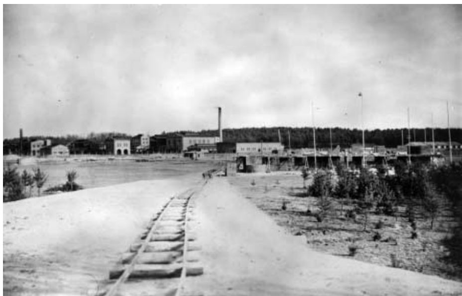
V roce 1928 se v areálu začala budovat továrna na dusíkaté látky, která dostala název Synthesie. Tento dceřiný závod byl s Explosiv úzce spjatý ve výrobní i správní oblasti. Snímek zachycuje staveniště závodu.
