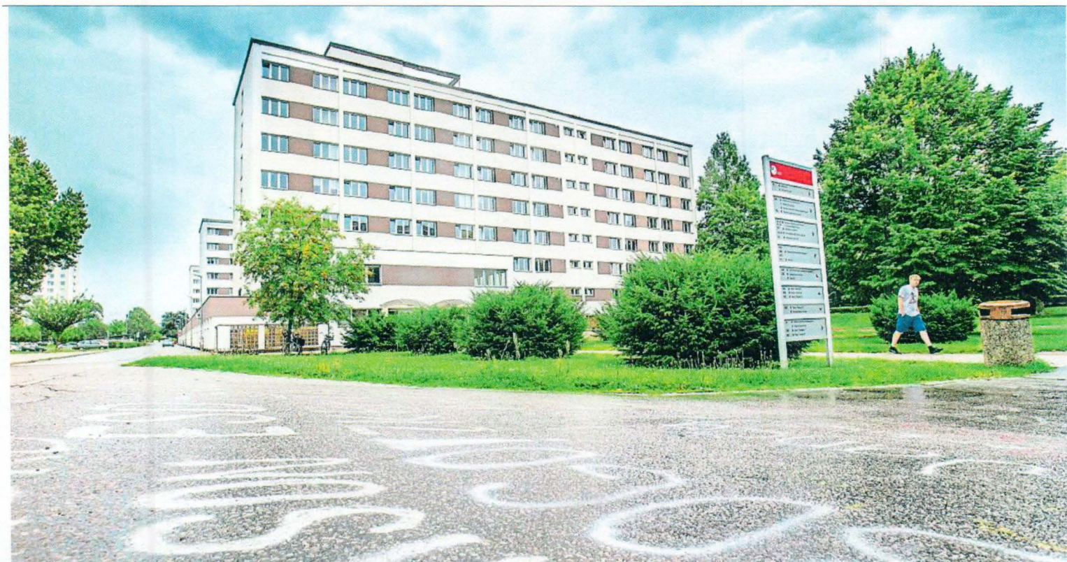
Vylepšené zázemí vysoké školy Pardubická univerzita vynaložila peníze na rekonstrukci jednoho pavilonu studentských kolejí. Foto: Radek Kalhous, MAFRA
